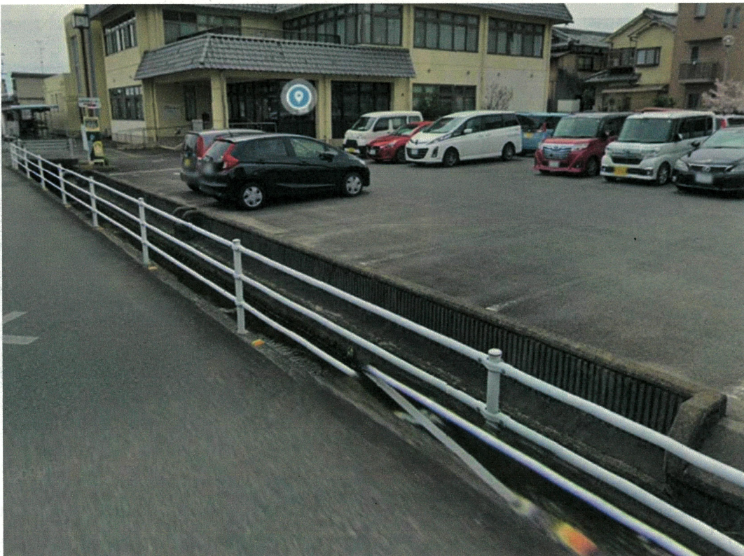
石部地区(湖南省市西庁舎)における状況 【平時】
